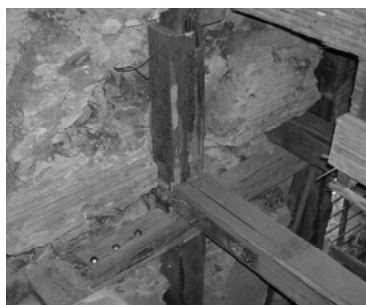
Integrazione di connessioni mancanti in ferro fra gli elementi; realizzazione di una piattabanda architravata mancante.
