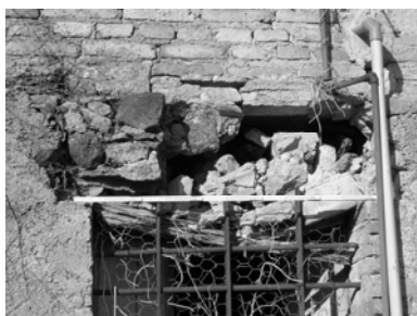
Integrazione di connessioni mancanti in ferro fra gli elementi; realizzazione di una piattabanda architravata mancante.
