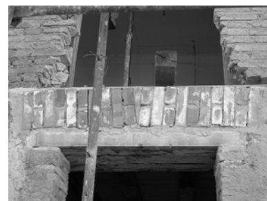
Integrazione di connessioni mancanti in ferro fra gli elementi; realizzazione di una piattabanda architravata mancante.
