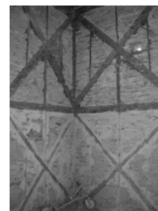
Riallineamento e sostituzione di pilastri e delle travi dei solai e dei diagonali della parete intelaiata
