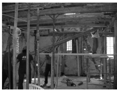
Riallineamento e sostituzione di pilastri e delle travi dei solai e dei diagonali della parete intelaiata
