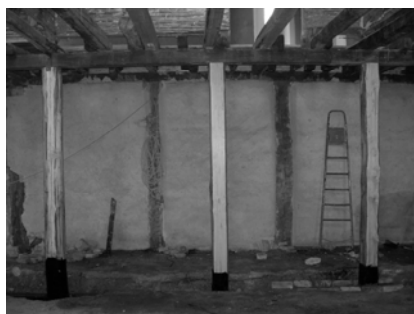
Riallineamento e sostituzione di pilastri e delle travi dei solai e dei diagonali della parete intelaiata
